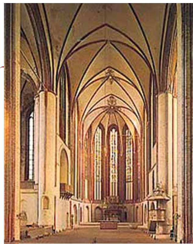
Interior de la Iglesia
